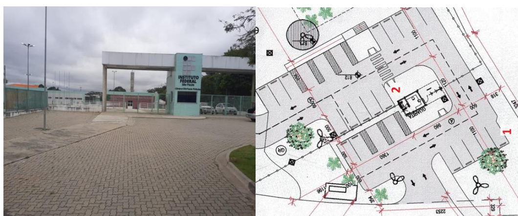
Figura 3.13. Estacionamento próximo à portaria
